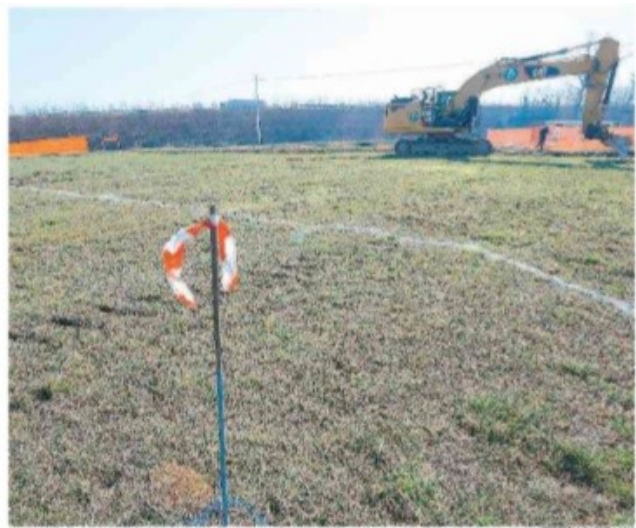
L'area delimitata in cui si comincerà a scavare nei prossimi giorni per realizzarvi la centrale
