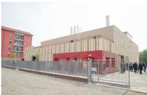
La centrale di teleriscaldamento «ridotto» che già alimenta una parte del rione Cristo
